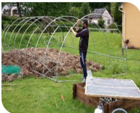
Pour fixer la bâche, vous devez creuser une tranchée le long de chaque côté du tunnel. La tranchée doit être profonde de 30 à 40 cm. Ensuite vous dépliez la bâche sur l'armature. Naturellement elle se déposera dans les tranchées. Il vous suffira alors de les reboucher avec la terre retirée. La bâche sera fixée grâce au poids de la terre et par des clips sur l'extrémité de l'armature.
